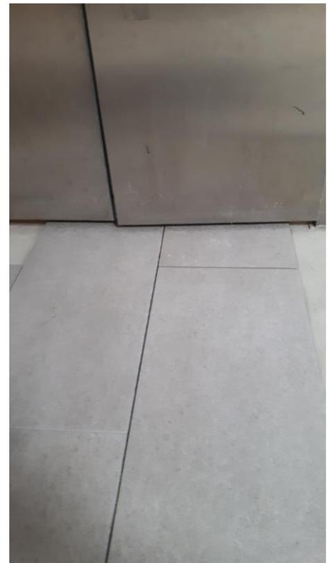
Aber auch die Türen der Schränke auf der Schießbahn mußten dem neuen Fußboden angepasst werden. Die Edelstahlplatten mit einem Trennschleider kürzen und die Holztür dann mit der Stichsäge abschneiden. Anschließend die Türen wieder einbauen, so dass darunter auch die Fliesen verlegt werden können.
