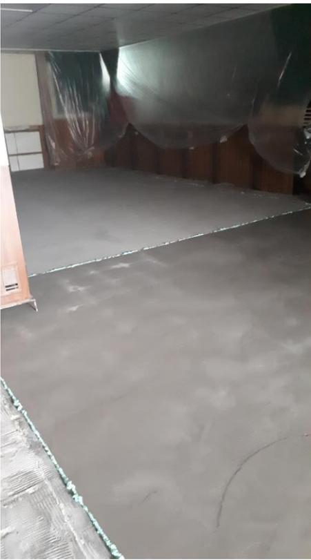
Nachdem die alten Fliesen entfernt wurden, mussten die Rest des alten Fliesenklebers zum Teil abgefräst und dann der Boden mit Ausgleichsmasse nivelliert werden.
