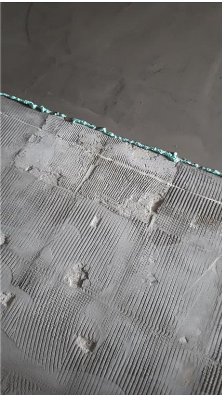
Der Boden vor und nach der Nivellierung. In der Mitte eine der Trennfugen.
